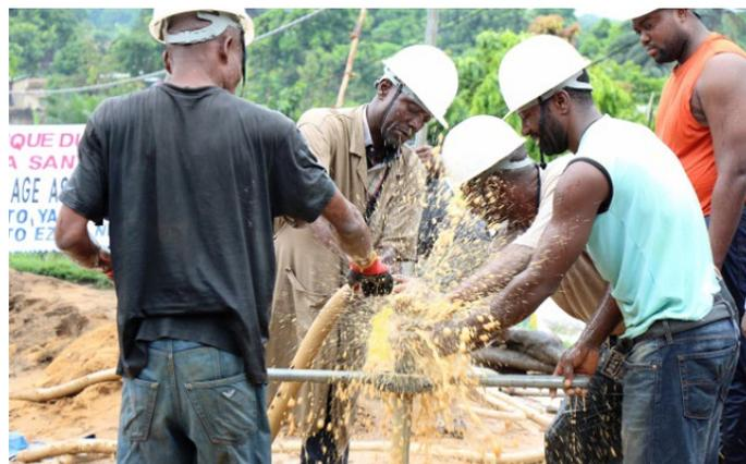
Image 14 Equipement de lançage à l'eau rotatif en RDC (source : UNICEF)
